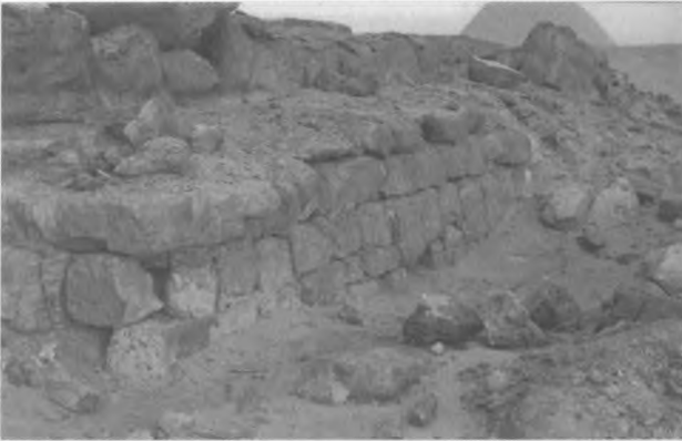
Pl. 7b. Vue du mastaba en calcaire de l'Ancien Empire, prise vers le Nord-Ouest le 15 janvier 1972 (Cliché MFFT / Ph. Brissaud).
